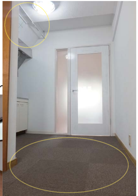
②半フロア床張替え・キッチン前カーテンレール取付け
